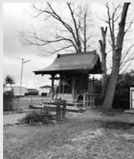
修復後の社殿
