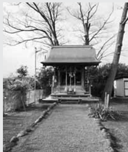
修復後の社殿
