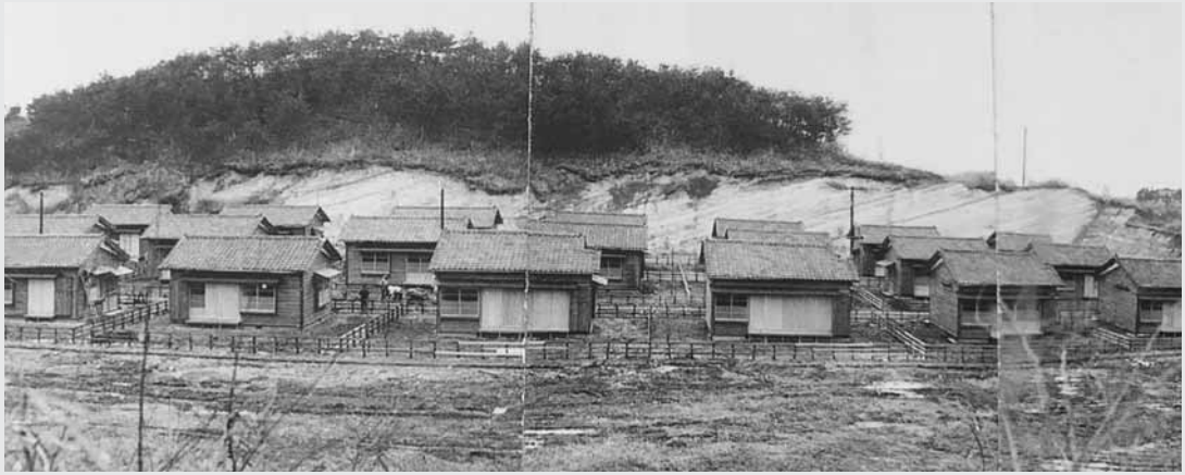
昭和38年3月18日に完成した町営混内山住宅は、20戸建てられた
