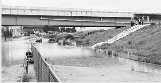
蟻ヶ袋、国道4号線が通行不能状態に。スマートインターへ行けません。
