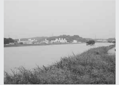
鳴瀬川の堤防も決壊寸前まで水位が上がりました。
